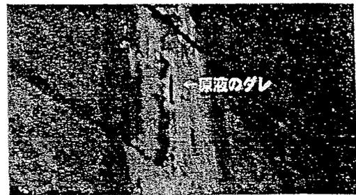
図 III.2.10 施工終了後の原液ダレ
